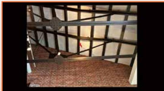
爆心地から約4.6kmのところはこの建物がありました。原爆投下による爆風によって、屋根を支える鋼鉄製の垂木が内側に折れ曲がるなどの被害を受けましたが、建物自体の倒壊は免れました。
